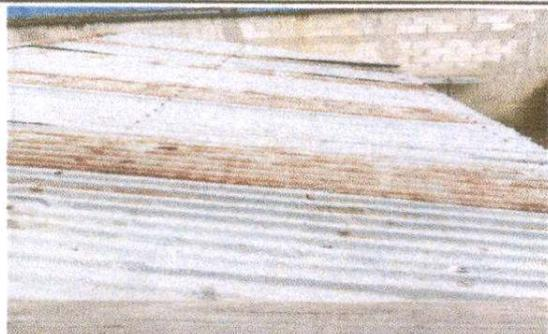
Foto1: 1.1 sustitución de lámina, por lámina troquelada aluzinc calibre 26
